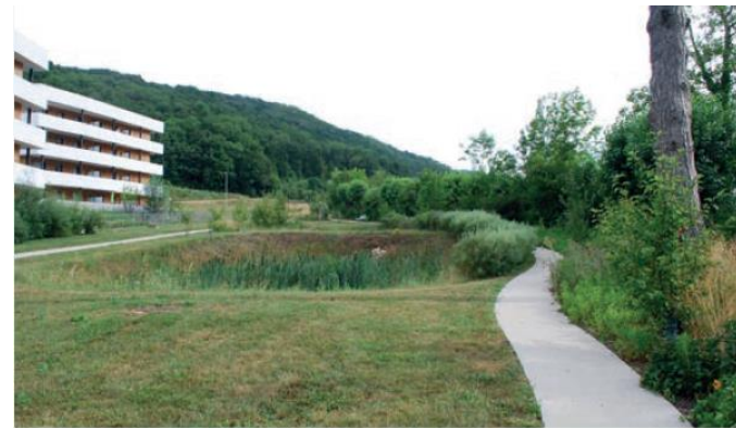
Exemple d'un bassin de récupération des eaux pluviales végétalisé
