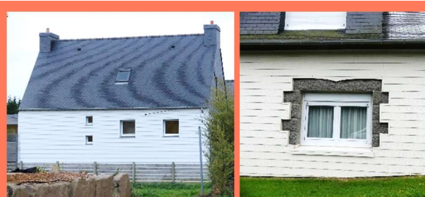
Isolation extérieure bardages PVC
