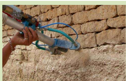
Isolation extérieure enduit chaux-chanvre
